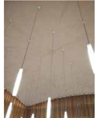
Die freitragende gewölbte Holzkuppel auf vier Eckpfeilern.
